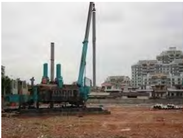
Рис. 4.– Устройство свайного фундамента из предварительно напряженных трубчатых свай-оболочек
