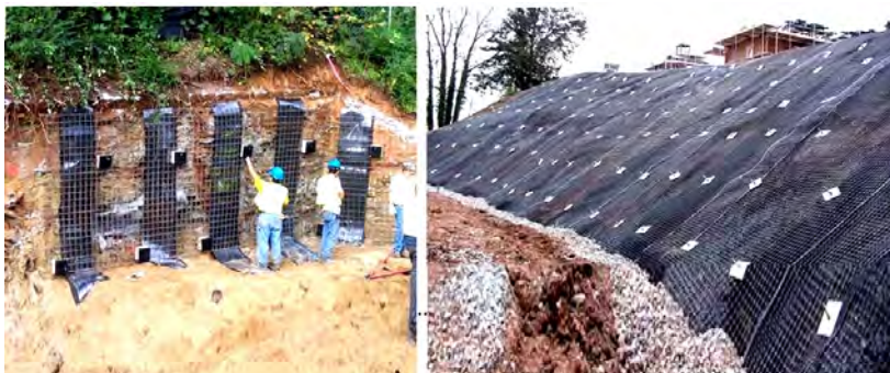
Рис. 6. Анкерование откосов и склонов в полевых условиях
