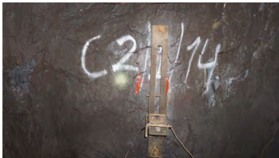
Рис. 4. Монтаж устройства на стенке горной выработки для выбуривания вертикальной разгрузочной щели до начала работ
