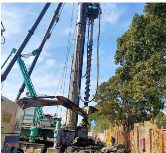
Рис. 3. Устройство глубоких буронабивных свай
