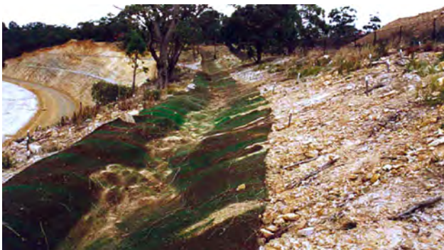
Рис. 4. Общий вид дренажной траншеи
