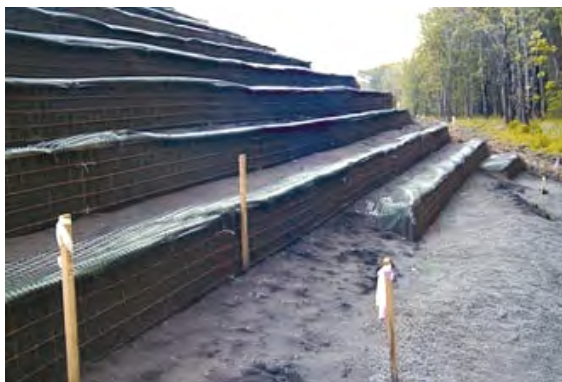
Рис. 3. Повышение устойчивости склонов формированием укрепленных ступеней
