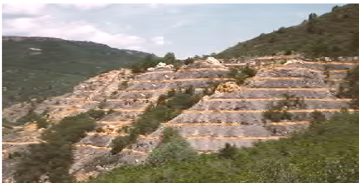
Рис. 2. Снижение оползнеопасной массы замещением легкими сельскохозяйственными материалами (соломенные тюки и др.)
