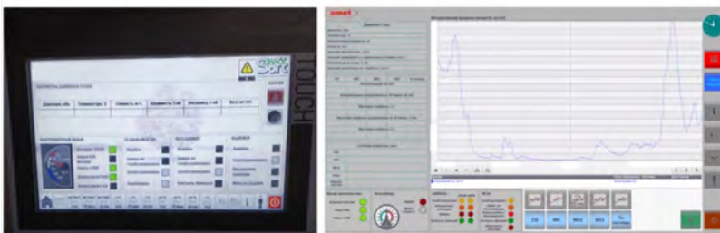
Рис.3. Общий вид программного обеспечения многофункционального комплекса телеметрии “Софт:Сигнал”-Ш-С-СИ v.Есо с системами жизнеобеспечения на базе промышленных контроллеров
