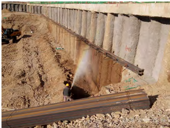
Рис. 2. Сооружение глубокого котлована под защитой подпорных стен из буронабивных свай, системы анкеров и набрызгбетона
