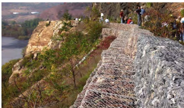
Рис. 8. Устройство габрионной стены вдоль шоссе
