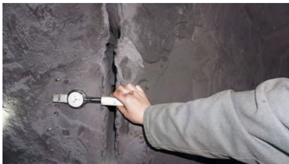
Рис. 5. Разгрузочная вертикальная щель выполнена при помощи устройства
