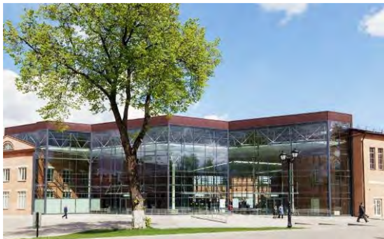
Рис.5 Музейно-выставочный комплекс в Тульском Кремле после реконструкции
