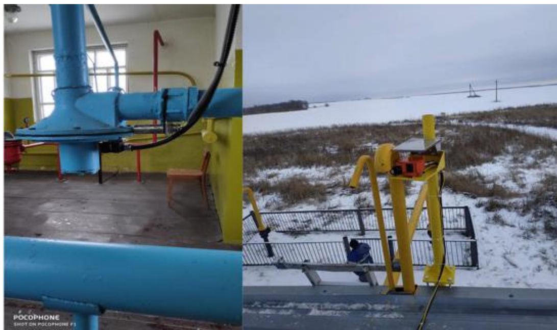
Рисунок 4.2 - Установка оборудования на ПСК и сбросной свече
