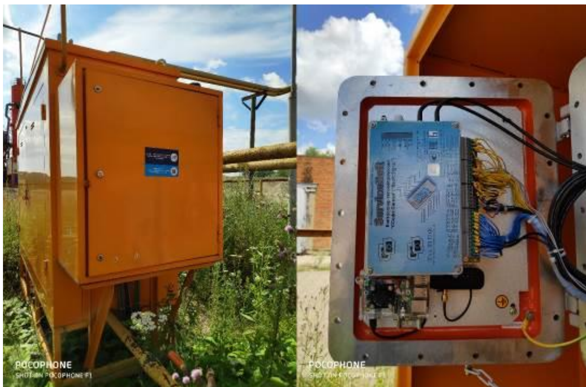
Рисунок 4.7 - Объект ГРПШ на АБЗ г. и установленный нейрокомпьютер (фото).
