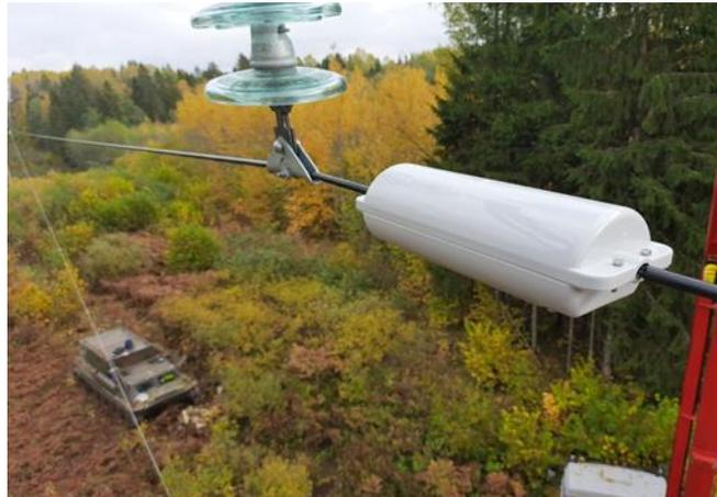
Рисунок 5.3.1 – Пример установки конструкции блока дистанционного мониторинга изоляторов ВЛ на провод ВЛ
