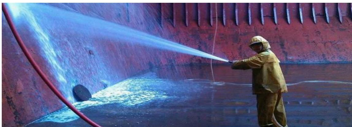
Рисунок 2.3 – Зачистка РВС (П) направленной водяной струей
